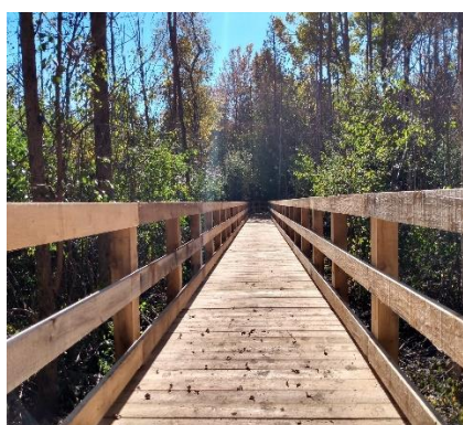
Photo 2 d'un trottoir de bois (phase 2)
